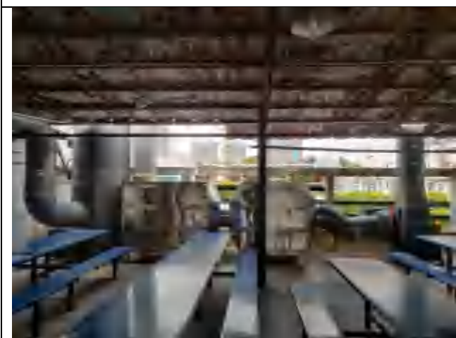
碱液喷淋+除雾装置+二级活性炭吸附装置
