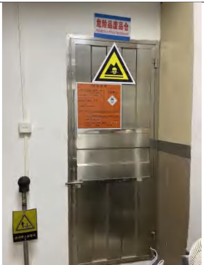
危废间门外标志牌
